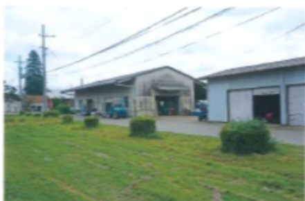
精米倉庫、機械庫
