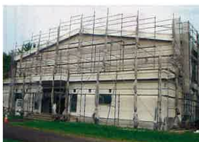
現体育館 (修繕工事中)
