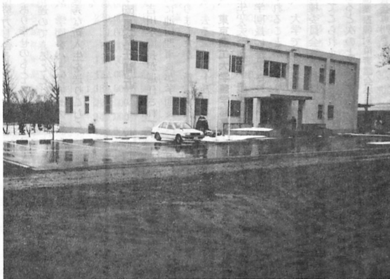
◀ グランドそばより眺めて南西に建つ総合教育棟(本館) ▶
