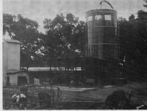
酪農場に建設されたスチールサイロ (積込量 180 t)
